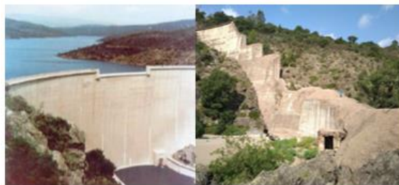
Figura 1. Falla de la presa de Malpasset (1959)
