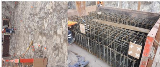
Figura 2. Cimentación sobre roca.
