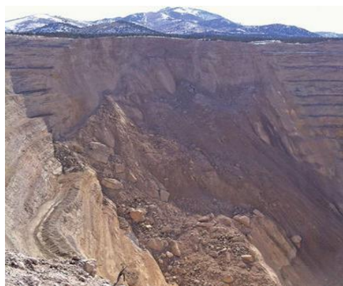
Figura 2. Falla del talud del Tajo Ruby Hill (2013)
