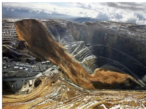
Figura 2. Falla del talud del Tajo Ruby Hill (2013)
